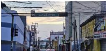
Los semáforos dejaron de funcionar en la calle Washington.
